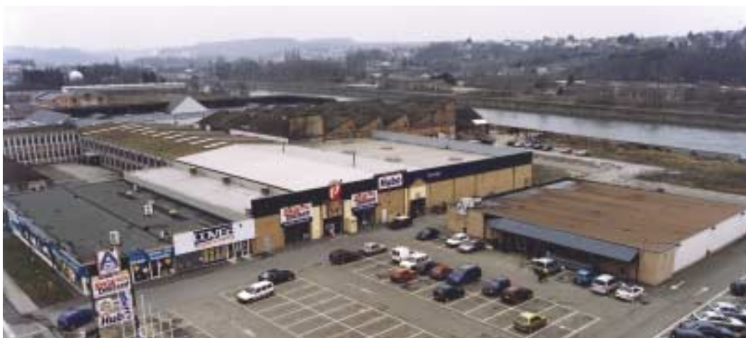
Avenue Roi Albert, Andenne
